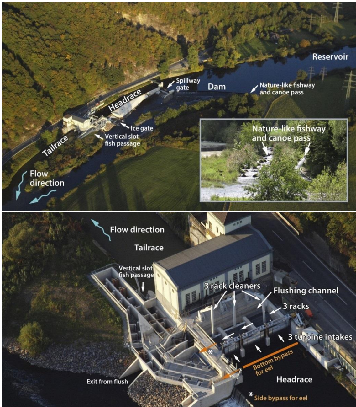
Abbildung 32: Die Wasserkraftanlage Unkelmühle an der Sieg. Die verschiedenen Abwanderwege sind mit Pfeilen markiert
