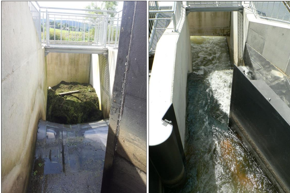
Abbildung 39: Bereich unmittelbar hinter dem Übergang der Geschwemmselrinne in die Sieg in dem sich 2014 (links) Geschwemmsel ansammelte und so wahrscheinlich Verluste verursachte. 2015 (rechts) trat dieses Problem nicht in vergleichbarem Umfang auf. Im linken Bild ist der Wasserstrom zwischenzeitlich unterbrochen gewesen.
