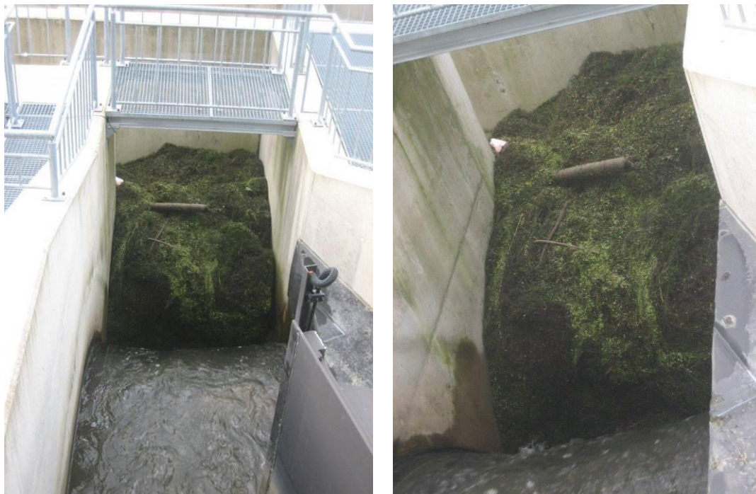
Abbildung 30: Geschwemmsel-Ansammlung (hier Wasserpflanzen) hinter dem Schwenktor 1
