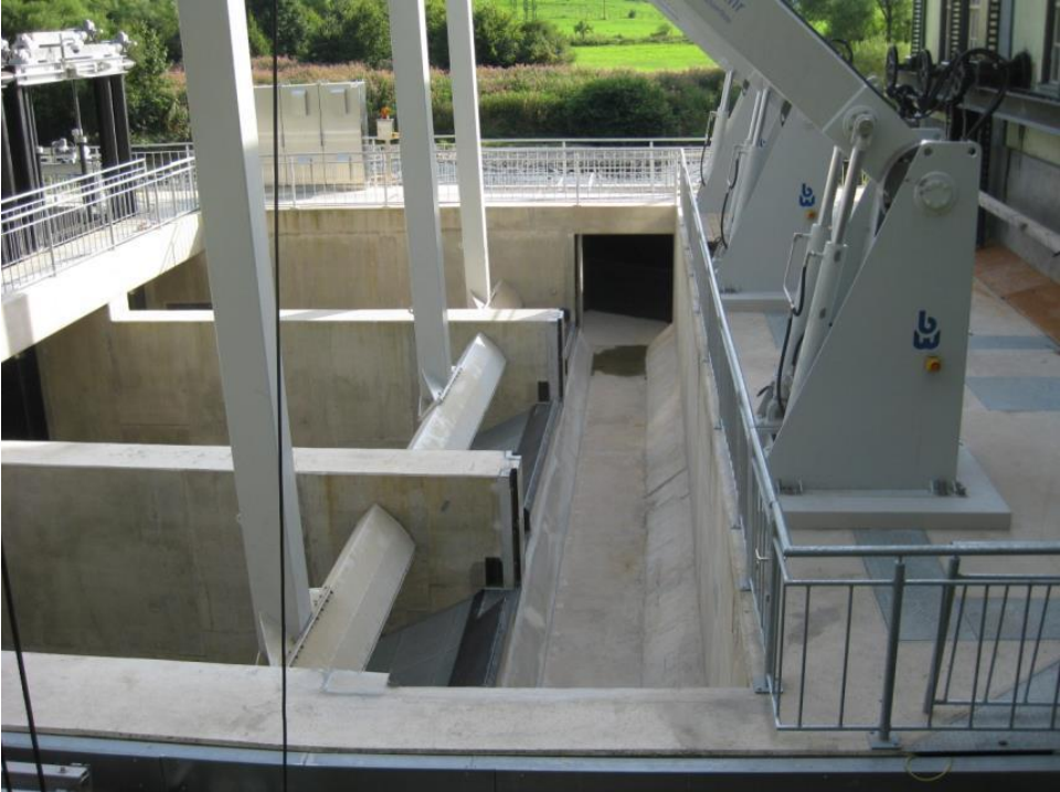
Abbildung 11: Fischabstiegsrinne mit Rechenschürze und Rechenreinigern
