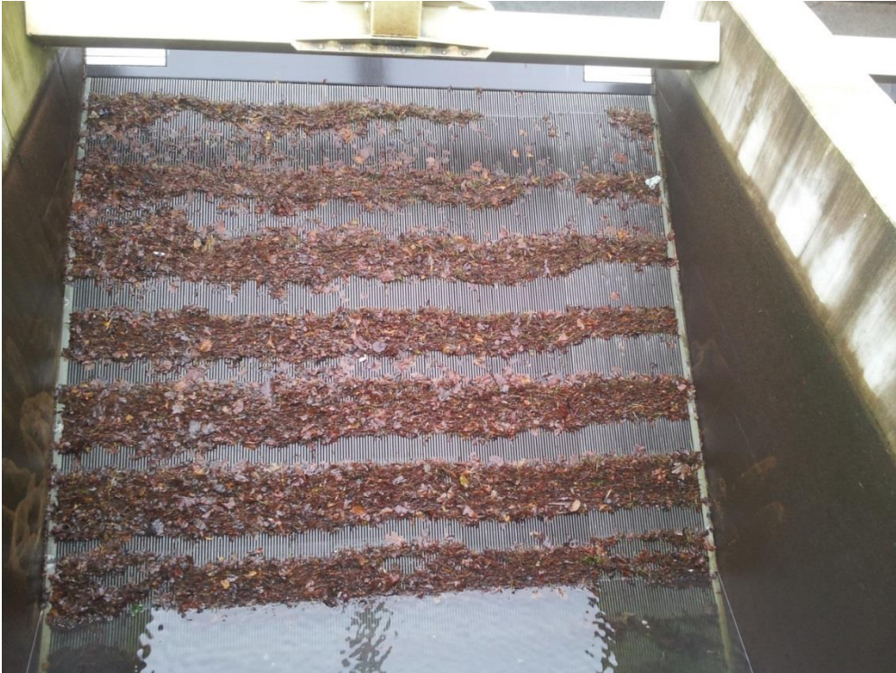
Abbildung 26: Teilverlegter Rechen 2 (Ansicht von vorne, November 2014)
